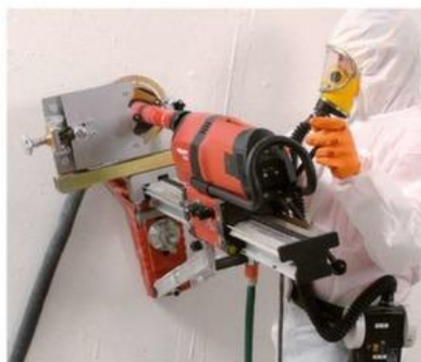
Testbohrung an einem biologischen Schild im Kernkraftwerk.
