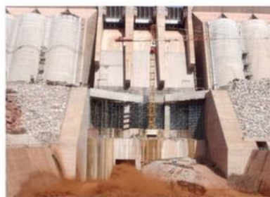
Sicht auf die beendete Seilsägearbeit an einem Staudamm.
